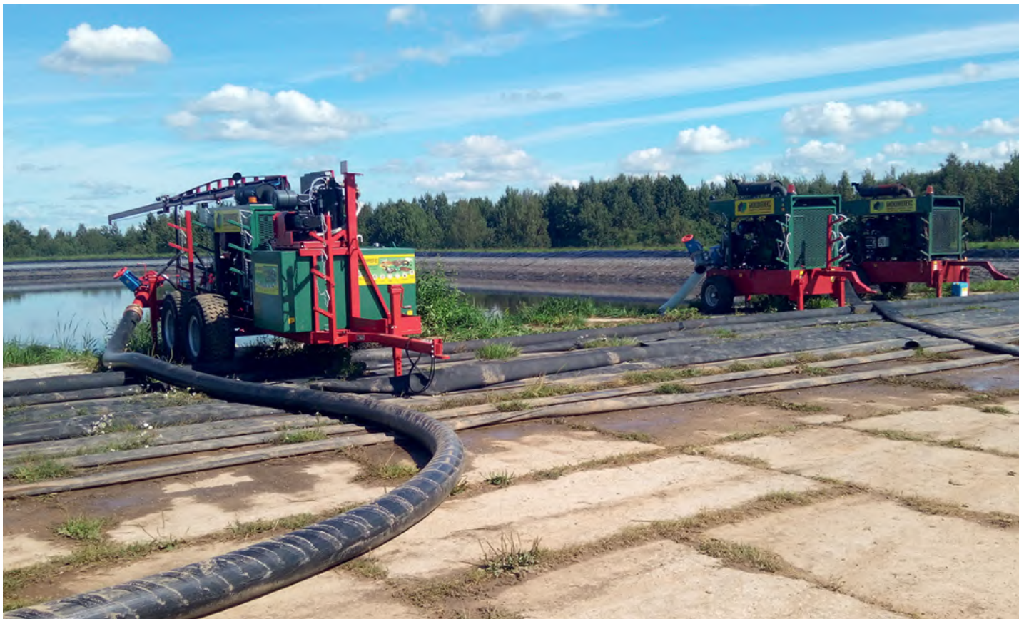
Дизельные насосные станции ГК «Биокомплекс» у навозохранилища
